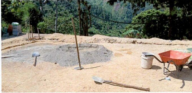
Foto1: Mantenimiento módulo tipo portico, cemento
