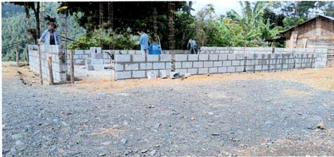
Foto 3: Mantenimiento módulo tipo portico, pared con block
