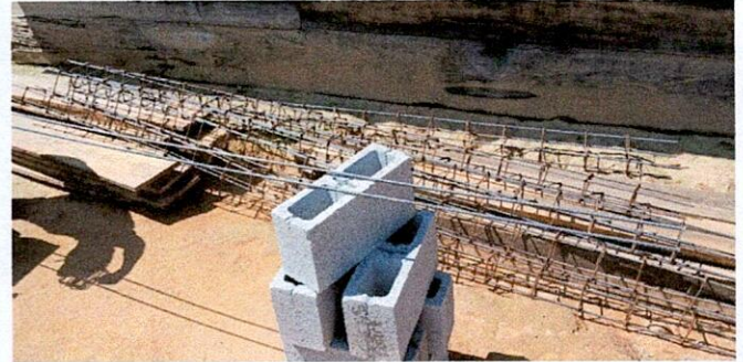
Foto 2: Mantenimiento módulo tipo portico, columnas
