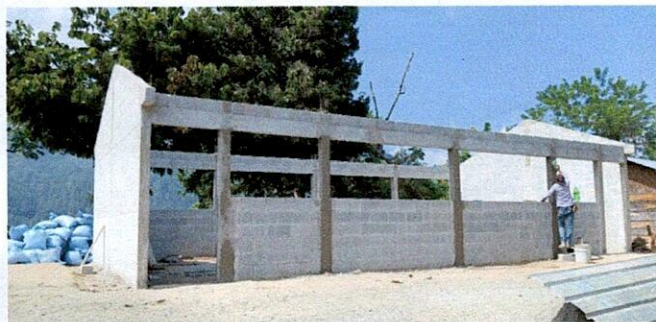
Foto 5: Mantenimiento módulo tipo portico, pared con block
