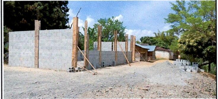
Foto 4: Mantenimiento módulo tipo portico, pared con block
